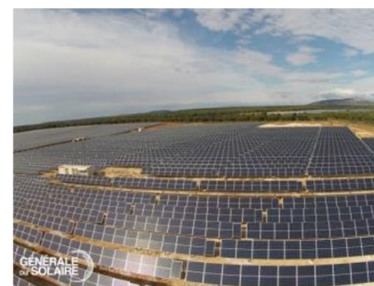
Centrale de Belvezet, Gard
