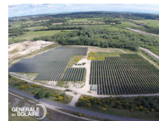
Centrale de Pujot, Gard
