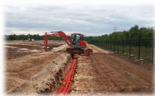
Enfouissement des réseaux
