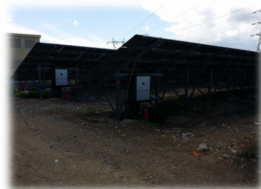
Illustration des équipements BT disposés en face arrière
