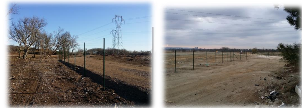
Exemple de pose de panneaux grillagés rigides
