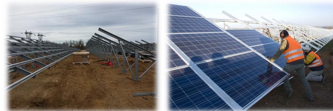
Montage des structures et pose des panneaux
