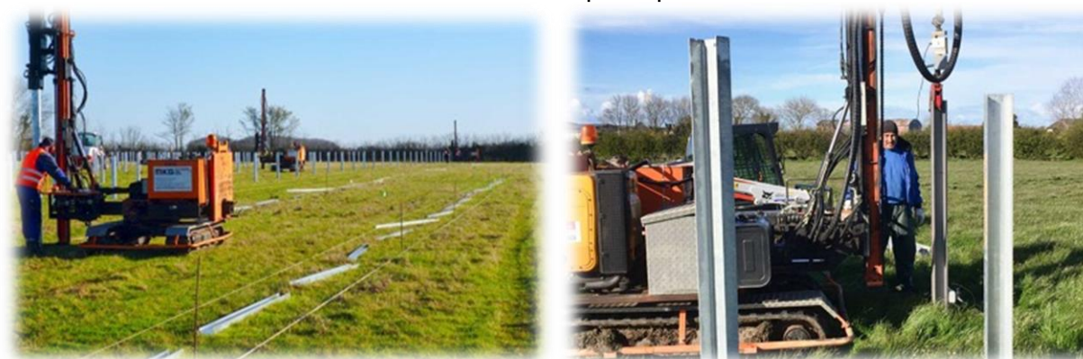
Exemple de batteuse de pieux (source mkg-goebel.de)
