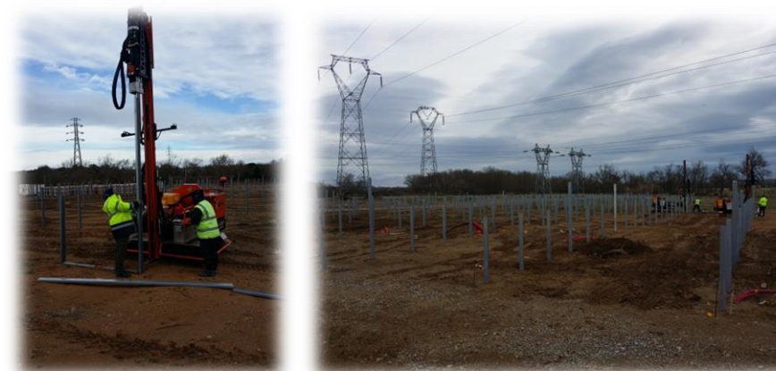
Mise en place des pieux battus
